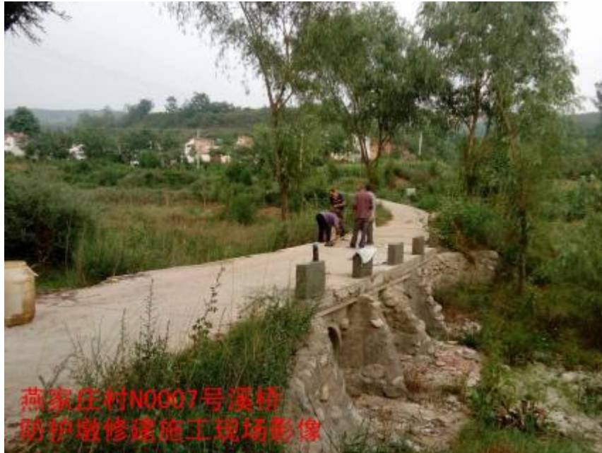
NO.007 燕家庄村店沟渠便民桥桥墩修建 在建
