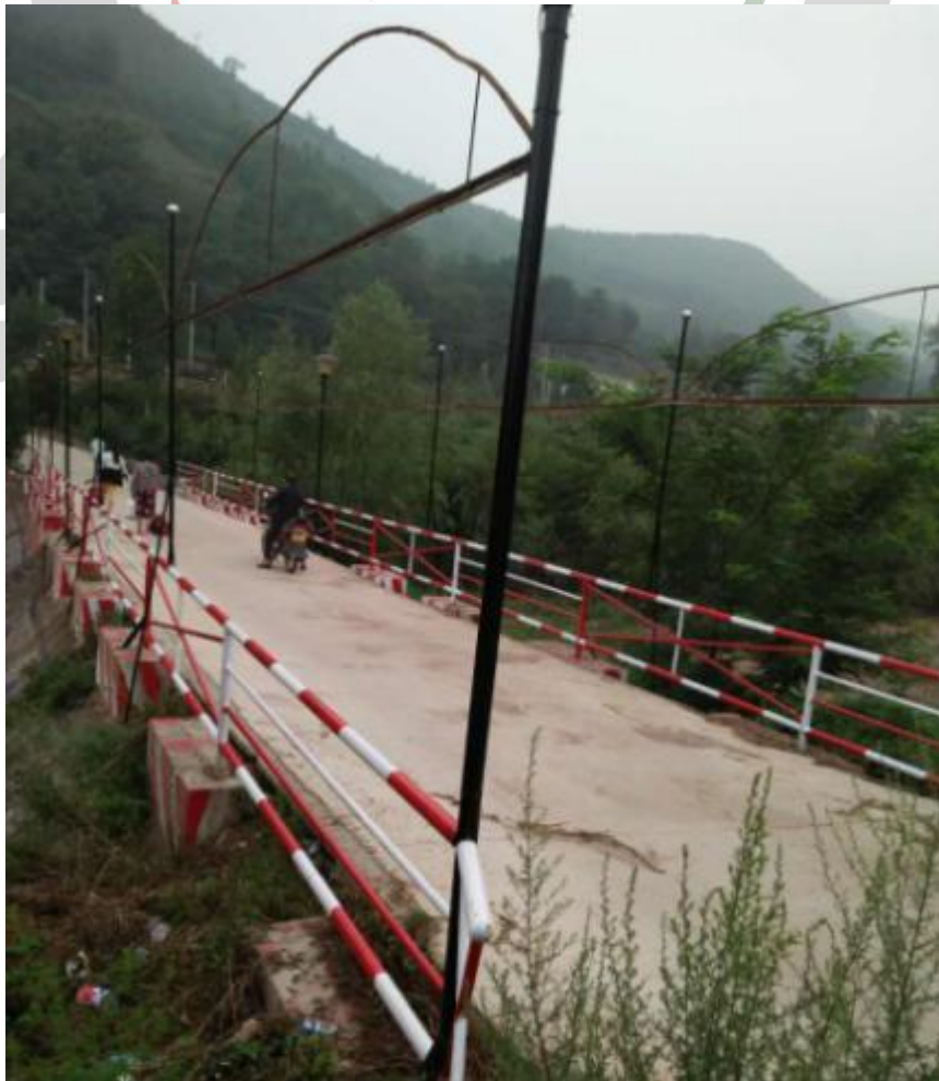
NO.008 燕家庄村葛条沟便民桥护栏修建 竣工
