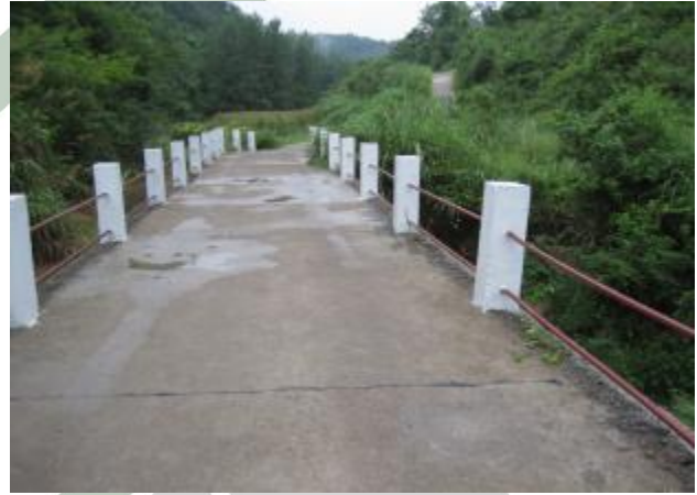
NO.33 田湾路桥
