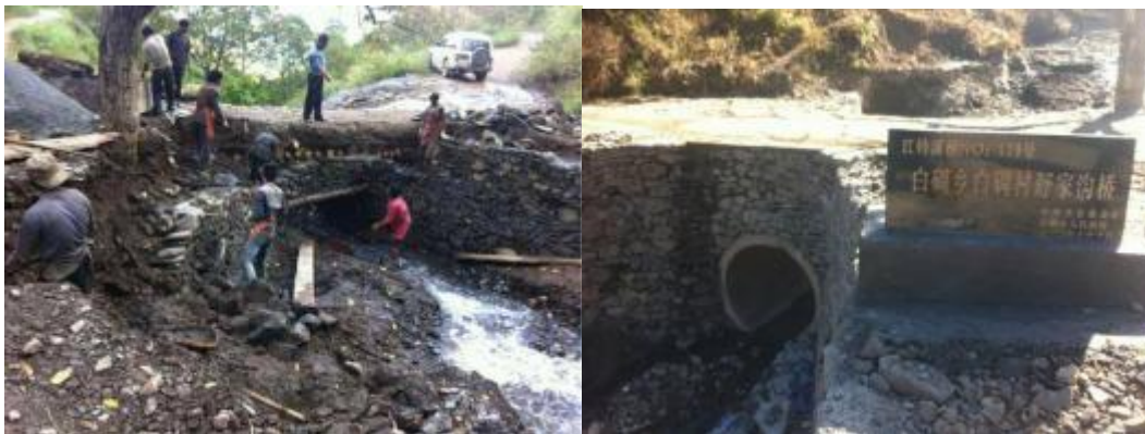
NO. 179 号白调乡白调村白调村舒家沟桥竣工
