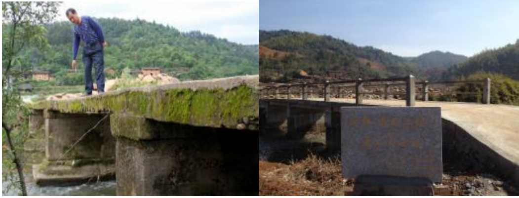
NO. 177 号抚地村盘石桥竣工
