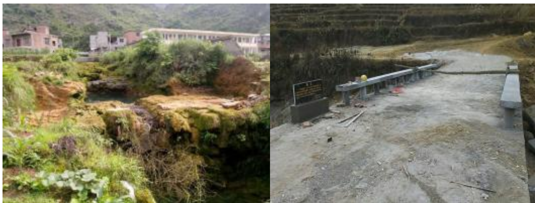
NO. 160 号龙山镇丫科村爱心桥竣工
