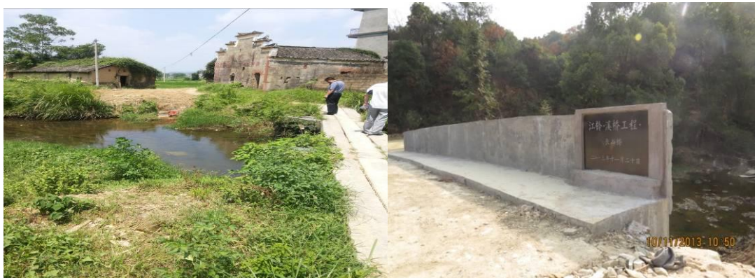
NO. 173 号县土塘镇冯坊村冯坊村长山桥竣工
