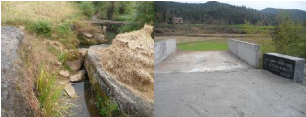
NO. 165 号国光乡、土门村土门桥竣工
