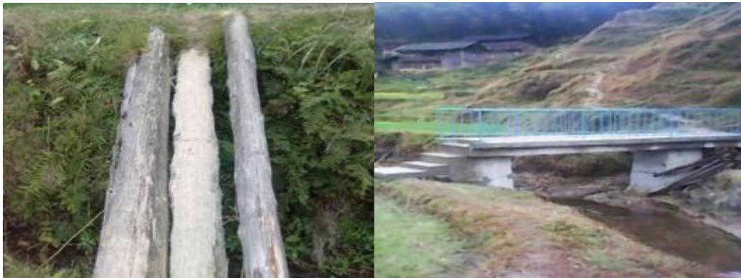
NO. 187 号定威乡亚勇村爱心桥竣工
