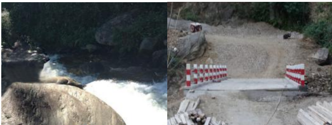
NO. 170 号子里甲乡金秀谷村金秀谷村桥竣工
