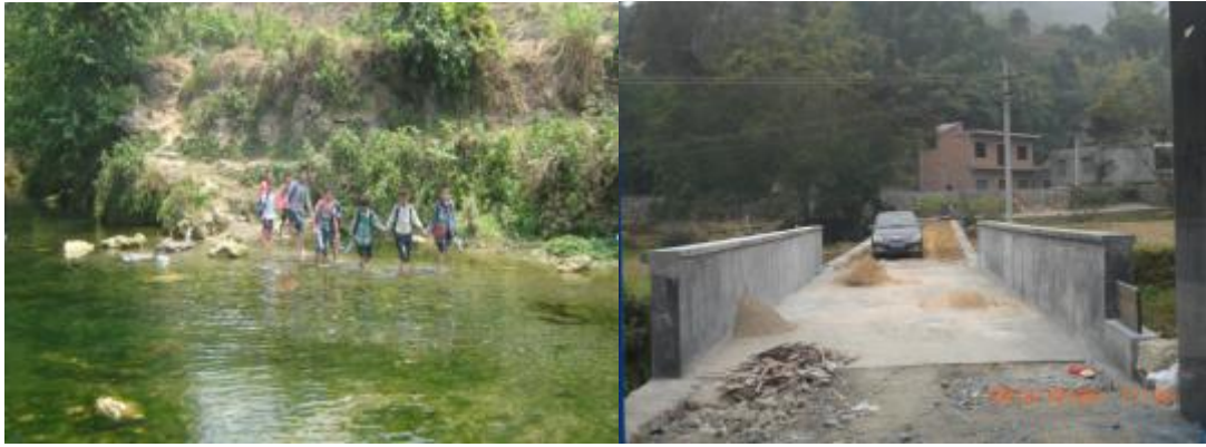
NO. 162 号坡脚乡八坎爱心桥 2 竣工
