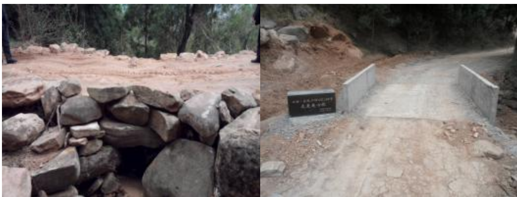
NO. 166 号开封镇、友爱村友爱桥竣工
