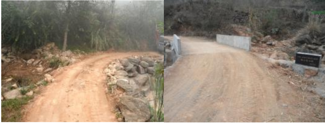
NO. 163 号开封镇鞍山村鞍山桥竣工
