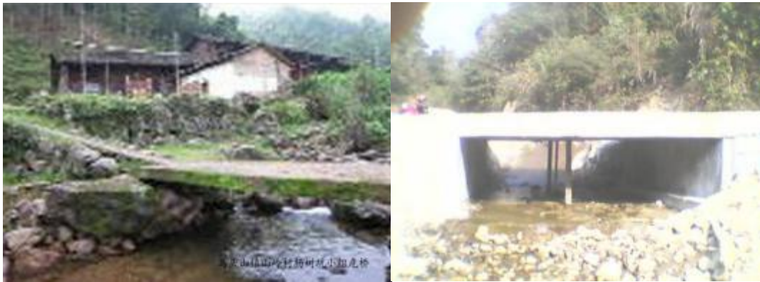
NO. 178 号下阳鞍山便民桥竣工
