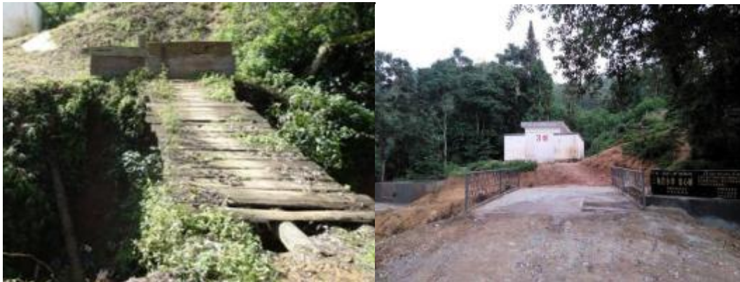
NO. 168 号勐戛镇三角岩村三角岩小学大桥竣工
