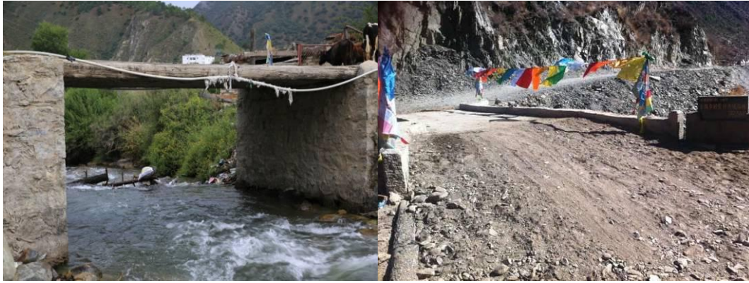
NO. 180 号东朗乡绒佐村乡绒佐村西绒沟桥竣工
