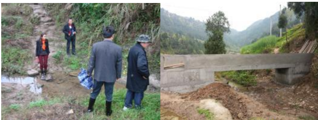
NO. 188 号定威乡亚勇村爱心桥竣工
