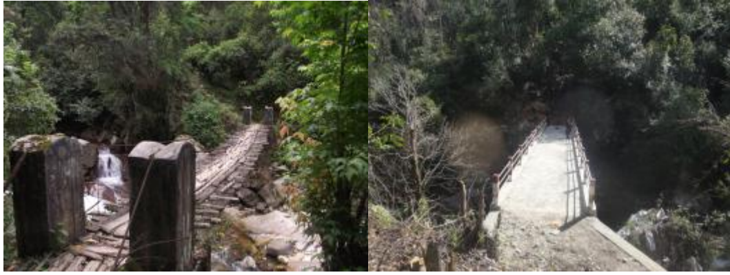
NO. 171 号马吉乡马吉米村噶吓桥竣工
