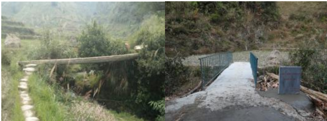
NO. 185 号定威乡计水村爱心桥竣工
