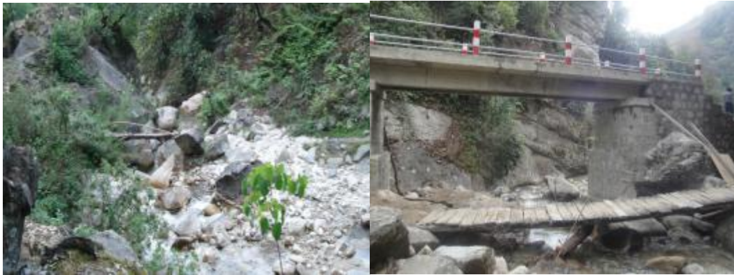
NO. 169 号上帕镇珠明林村珠明林村桥竣工
