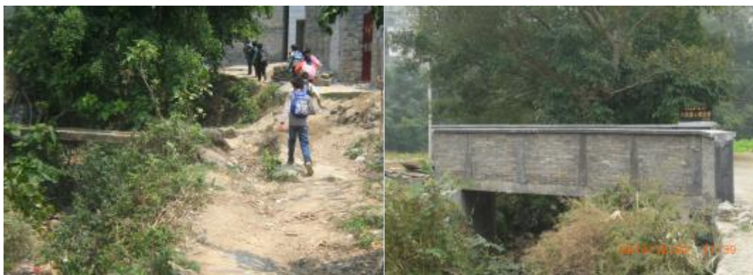
NO. 161 号坡脚乡八坎爱心桥 1 竣工
