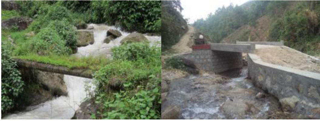
NO. 183 号风平镇上东村葫芦口河桥竣工
