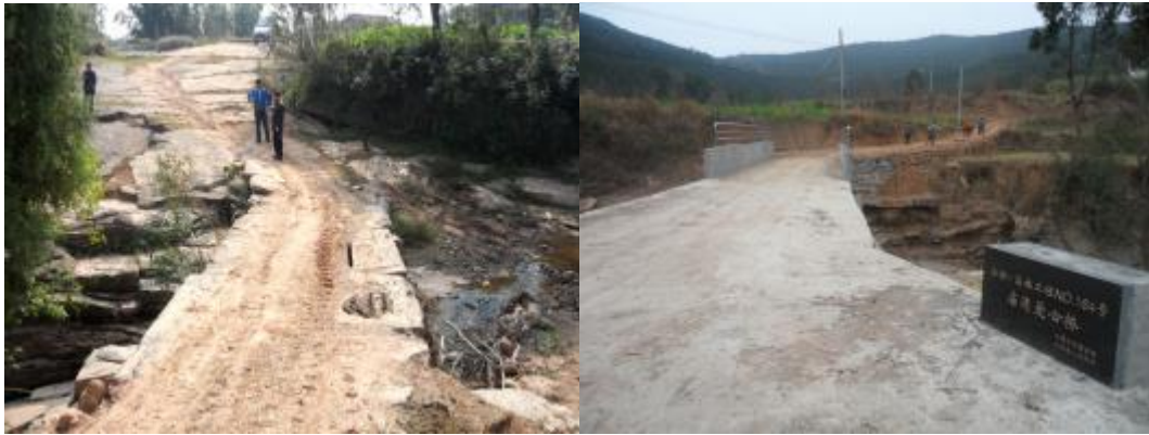
NO. 164 号碗泉乡庙湾村庙湾桥竣工
