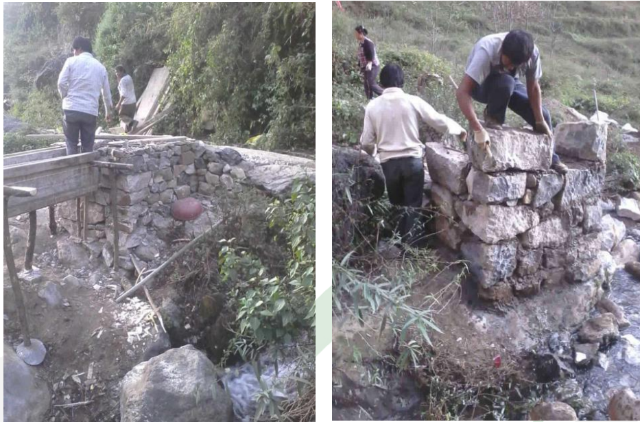
图二十：梭山镇妥乐大庆沟头基础施工
