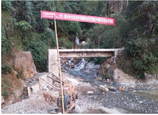
图二十六：妥乐村大庆龙井沟爱心桥浇筑桥面
