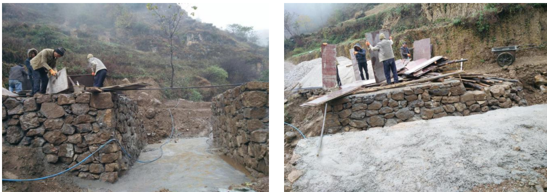
图十七：乐红镇红布村大坪子 1 号桥基础施工
