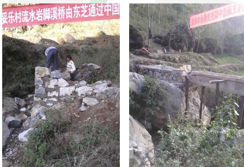
图三十一：梭山镇妥乐大庆流水岩脚爱心桥基础施工
