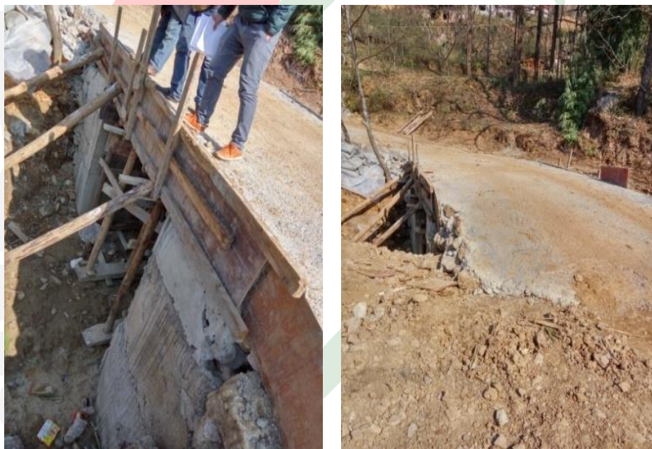
图十八：乐红镇红布村大坪子 1 号桥桥面布筋浇筑
