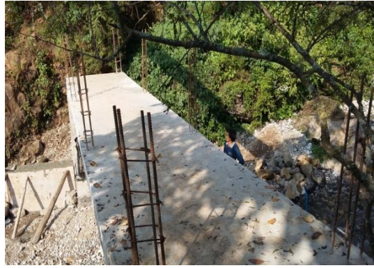
图二十六：妥乐村大庆龙井沟爱心桥浇筑桥面
