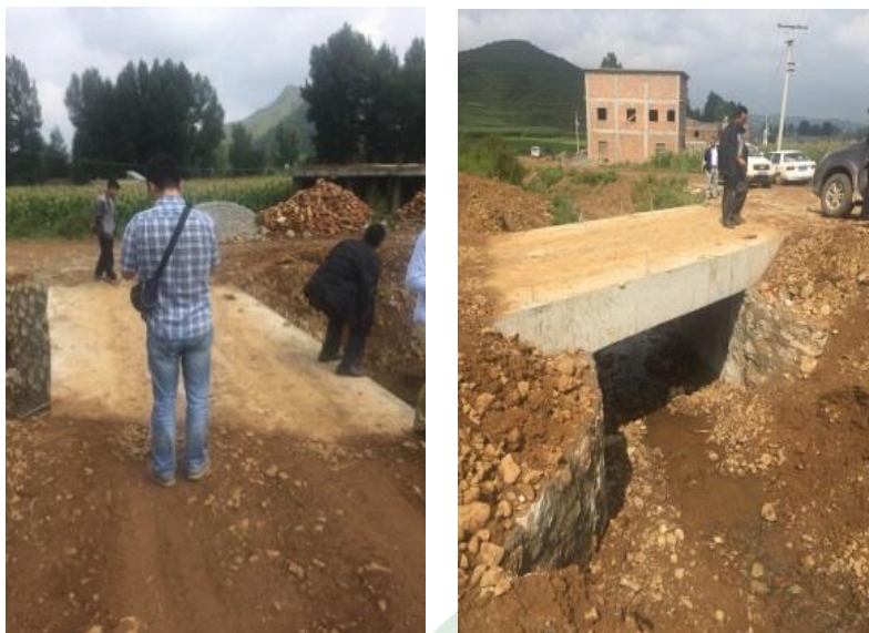
图十一：龙树镇塘房 27 社车行桥基础施工
