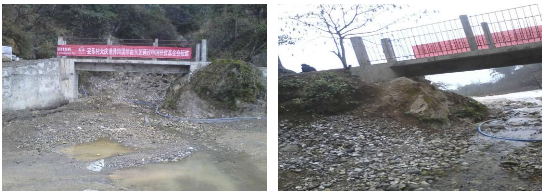
图二十二：梭山镇妥乐大庆沟头主体基本完工
