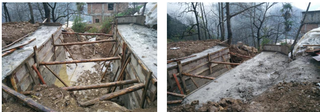
图十四：乐红镇红布村大毛坡基础施工
