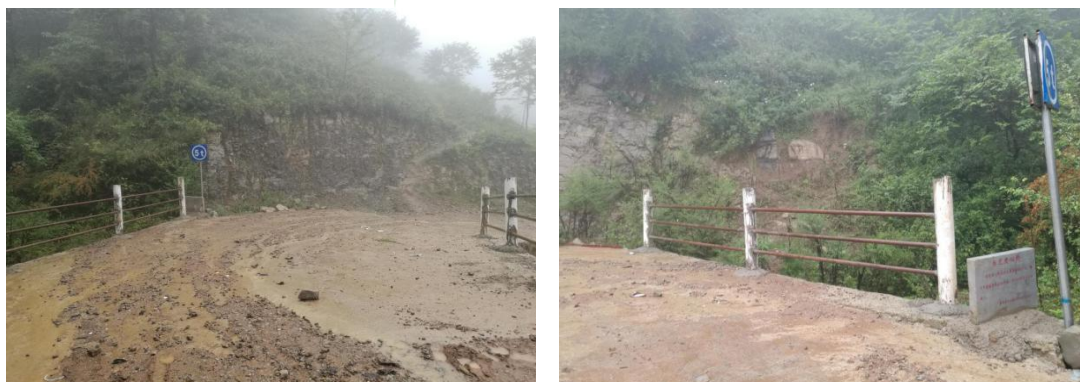
图十六：红布村大毛坡社主体完工
