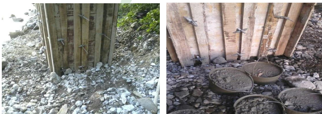
图二十五：妥乐村大庆龙井沟爱心桥桥墩施工
