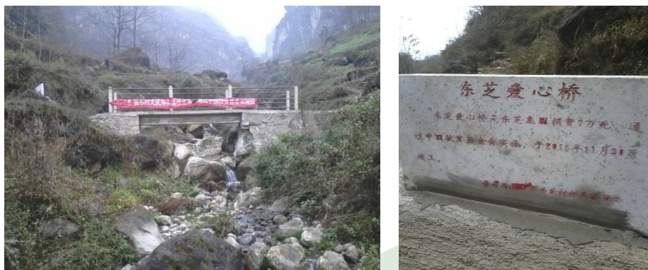
图二十三：梭山镇妥乐村大庆沟头主体已投入使用
