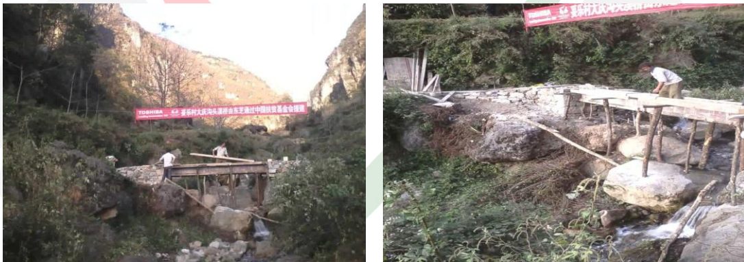
图二十一：梭山镇妥乐大庆沟头浇筑桥面
