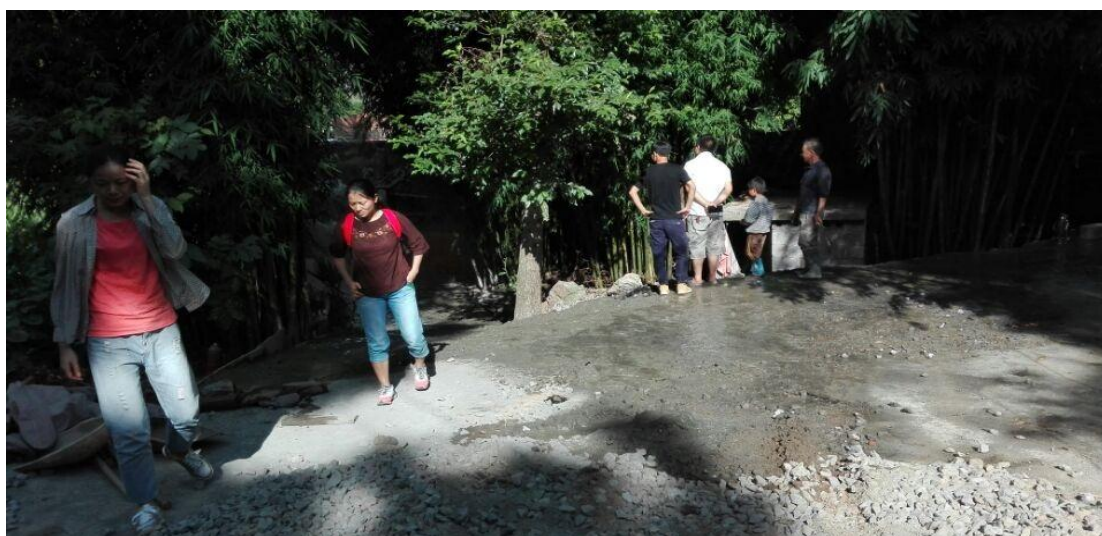
施工中的道路
