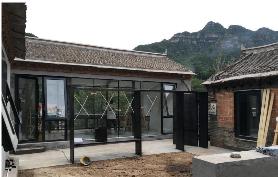
施工完成的 1 号院咖啡厅
