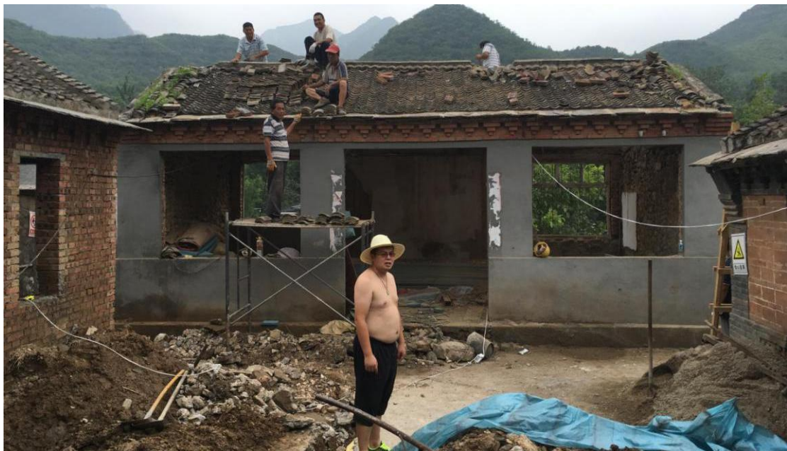
施工中的民宿 1 号院
