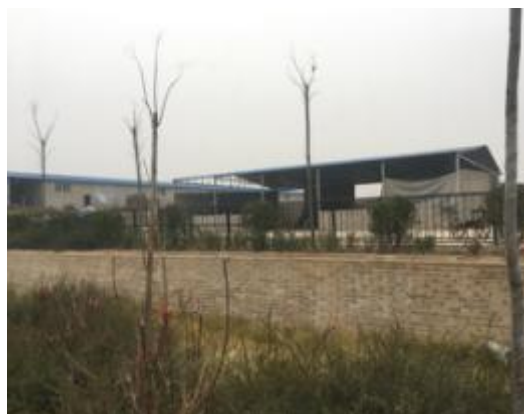
图△：现代化养殖场二期改造中
