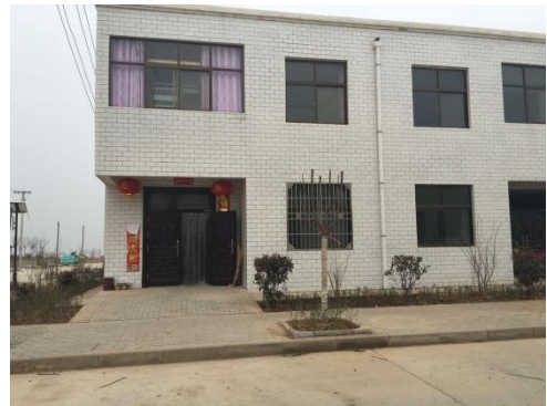
图△：搬迁后的房屋
