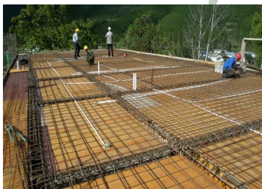
9月19日，正在进行钢筋绑扎及屋面模板安装
