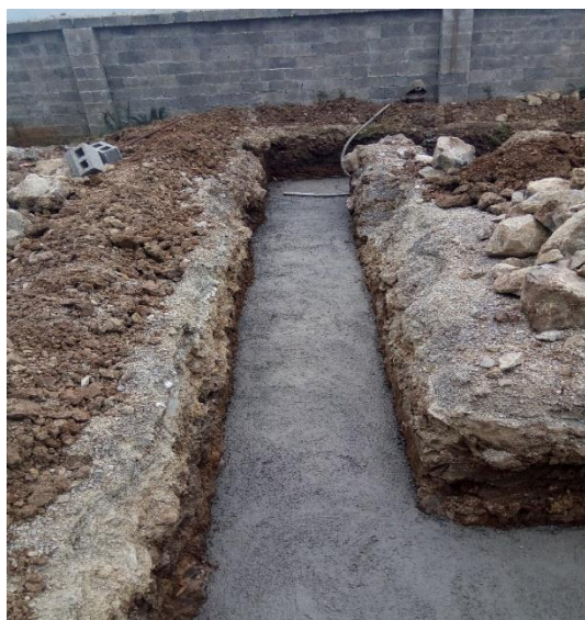
9 月，基础垫层浇筑完成
