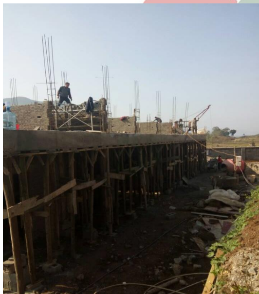
10 月底，旦坪学校主体一层建设完成，正在砌砖
