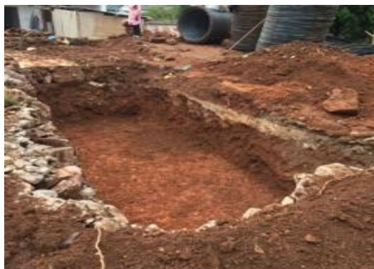
8月8日，进行基础开挖工作
