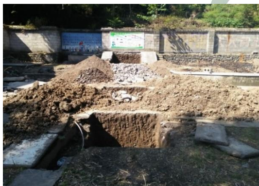
8 月底，正在开挖基槽
