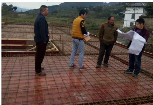
11 月底，旦坪学校二层板面支模完成，准备浇筑
