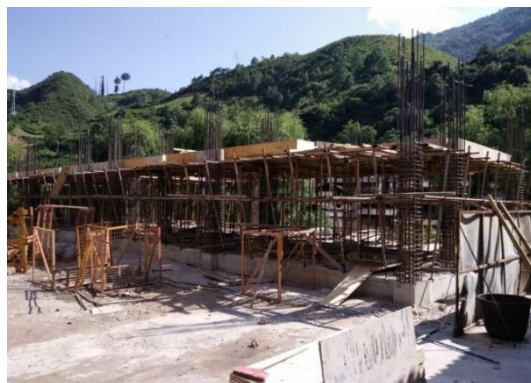
9 月底，一层板面混凝土浇筑完成
