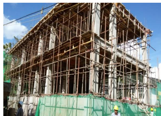
9月19日，正在进行钢筋绑扎及屋面模板安装
