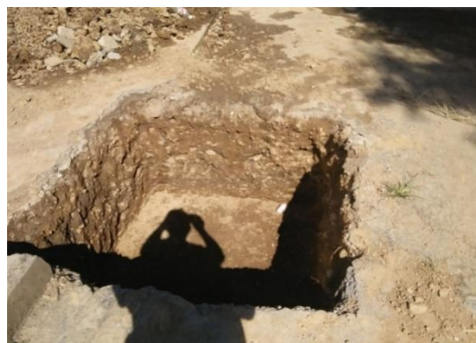
8 月底，正在开挖基槽
