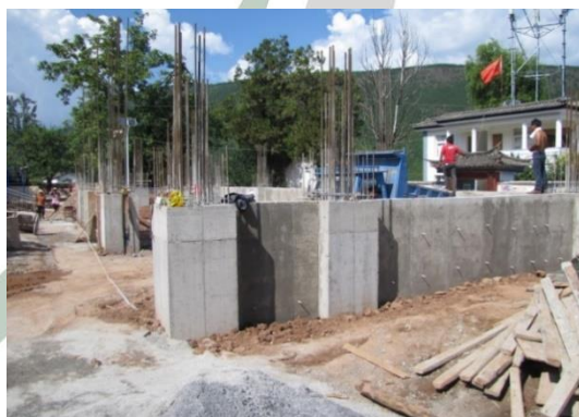
8月23日，地圈梁下挡土墙浇筑基本完成
