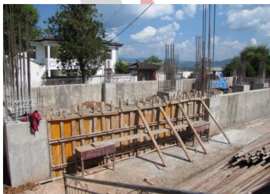
8月23日，地圈梁下挡土墙浇筑基本完成
