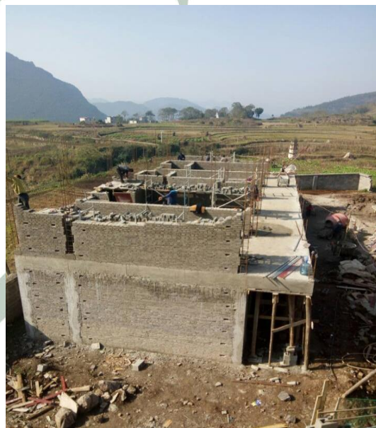
10 月底，旦坪学校主体一层建设完成，正在砌砖
