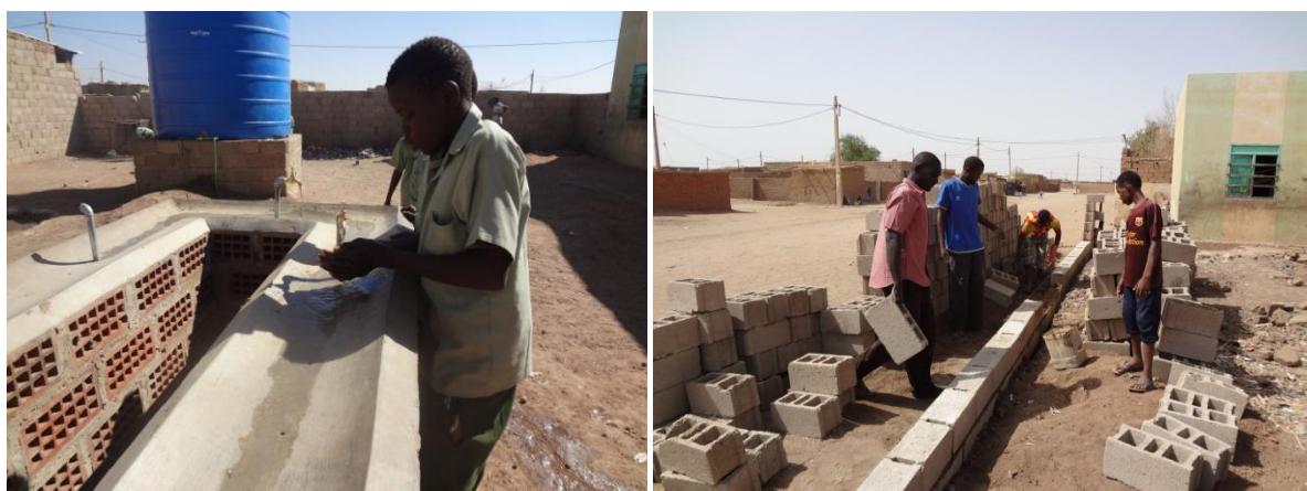
饮水设施修建完成投入使用
