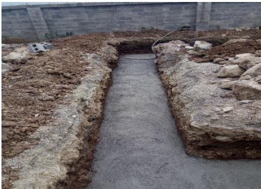
2016年9月，基础垫层浇筑完成
