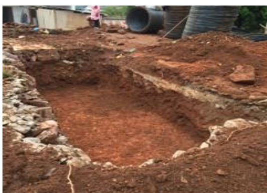
2016年8月8日，进行基础开挖工作
