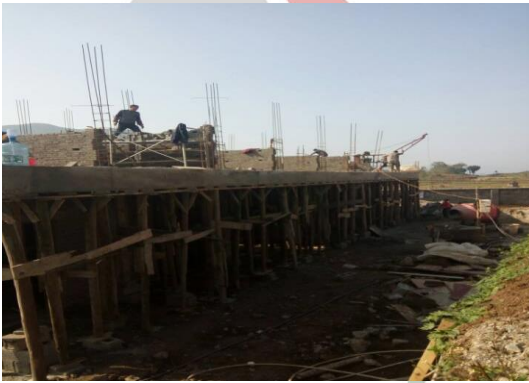
2016年10月底，旦坪学校主体一层建设完成，正在砌砖
