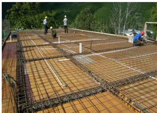
2016年9月19日，正在进行钢筋绑扎及屋面模板安装
