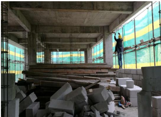
12月10日，弥沙完小宿舍楼主体封顶，正在砌砖
