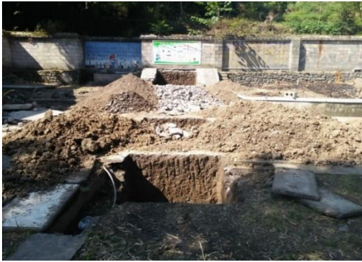
8月底，正在开挖基槽
