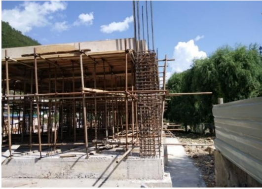
2016年9月底，一层板面混凝土浇筑完成
