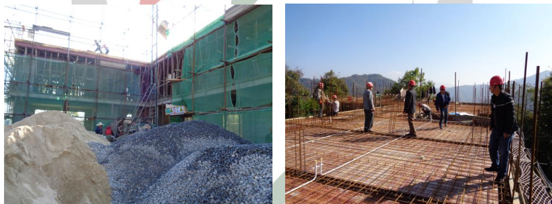
组图 7：2 月底，小米地小学二层屋面钢筋绑扎完成
