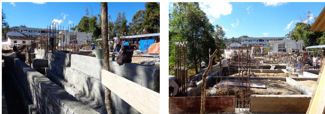
组图 6：小米地小学基础地圈梁混凝土浇筑完成
