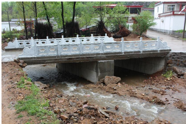
NO.288 陈沟爱心桥 (已竣工)
