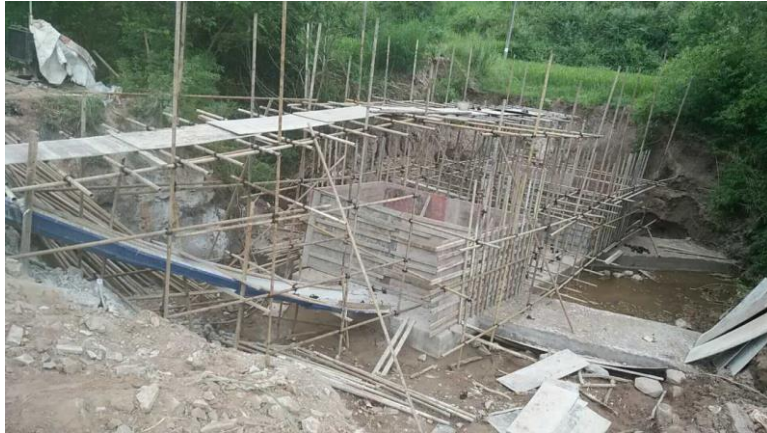
NO.278 水洞连心桥 (在建)
