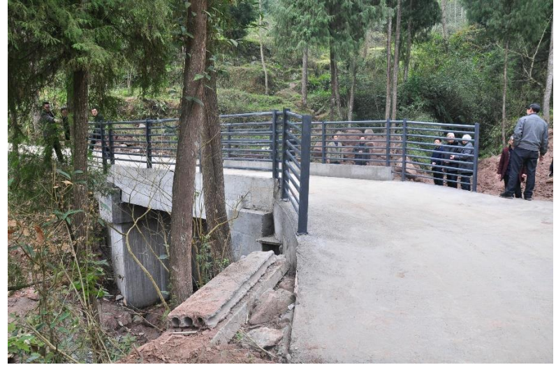
NO.277 桐籽园小桥 (已竣工)
