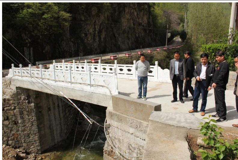
NO.290 西竹园爱心桥 (已竣工)
