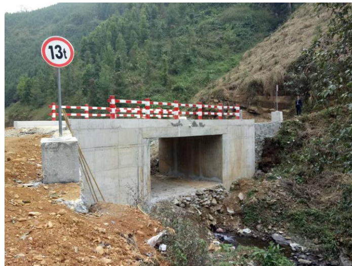
NO.022 那哈桥 (已竣工)
