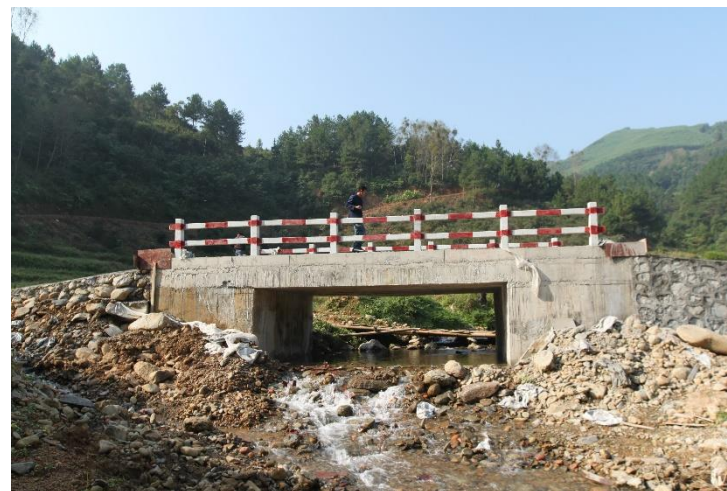
NO.014 东浪桥 (已竣工)
