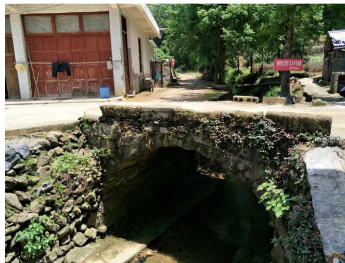
NO.312 多水铺桥 (原貌照片)
