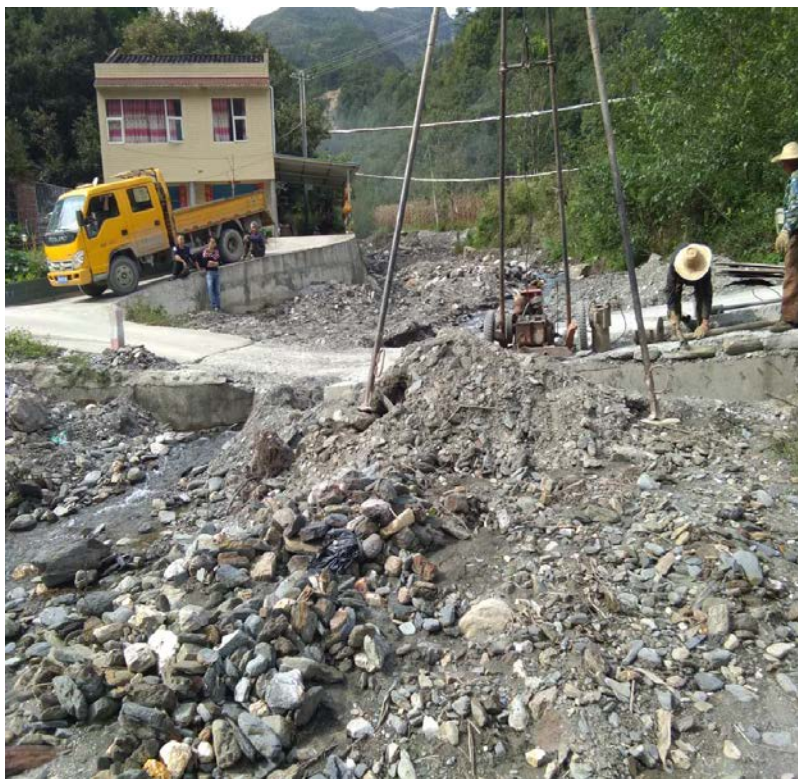
河坝爱心桥（地勘照片）
