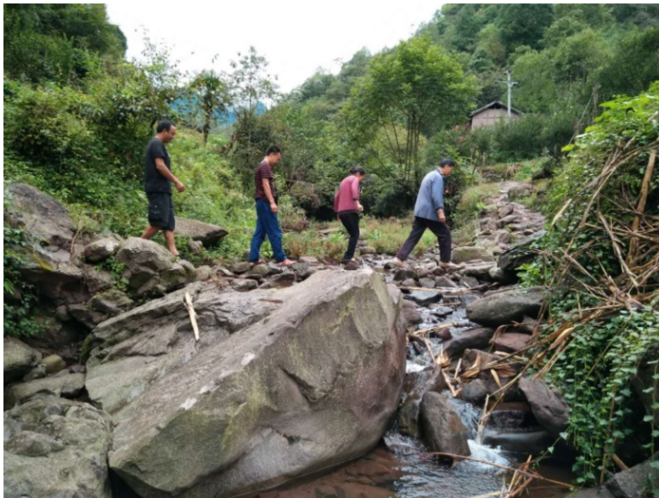
徐家沟幸福桥（原貌照片）
