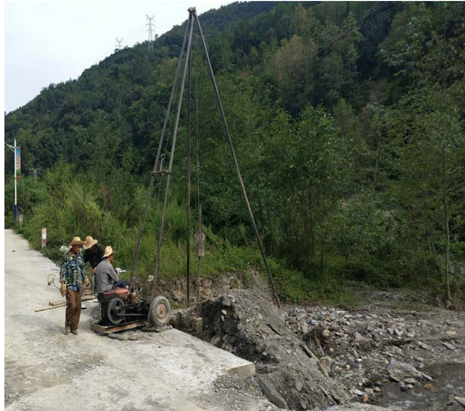
蔡家沟爱心桥（地勘照片）
