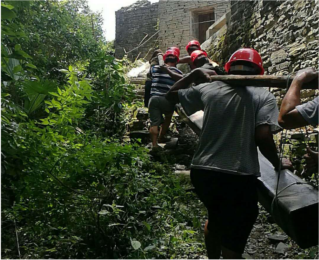
项目施工——工人搬运建材
