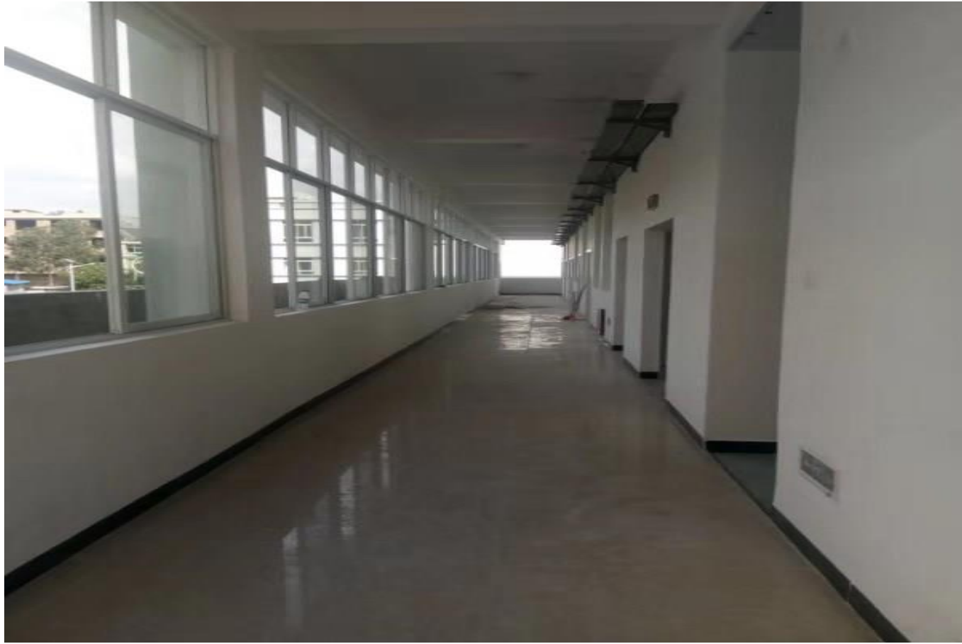
麻栗坡县杨万卫生院业务用房完成墙体抹灰和地板铺装
