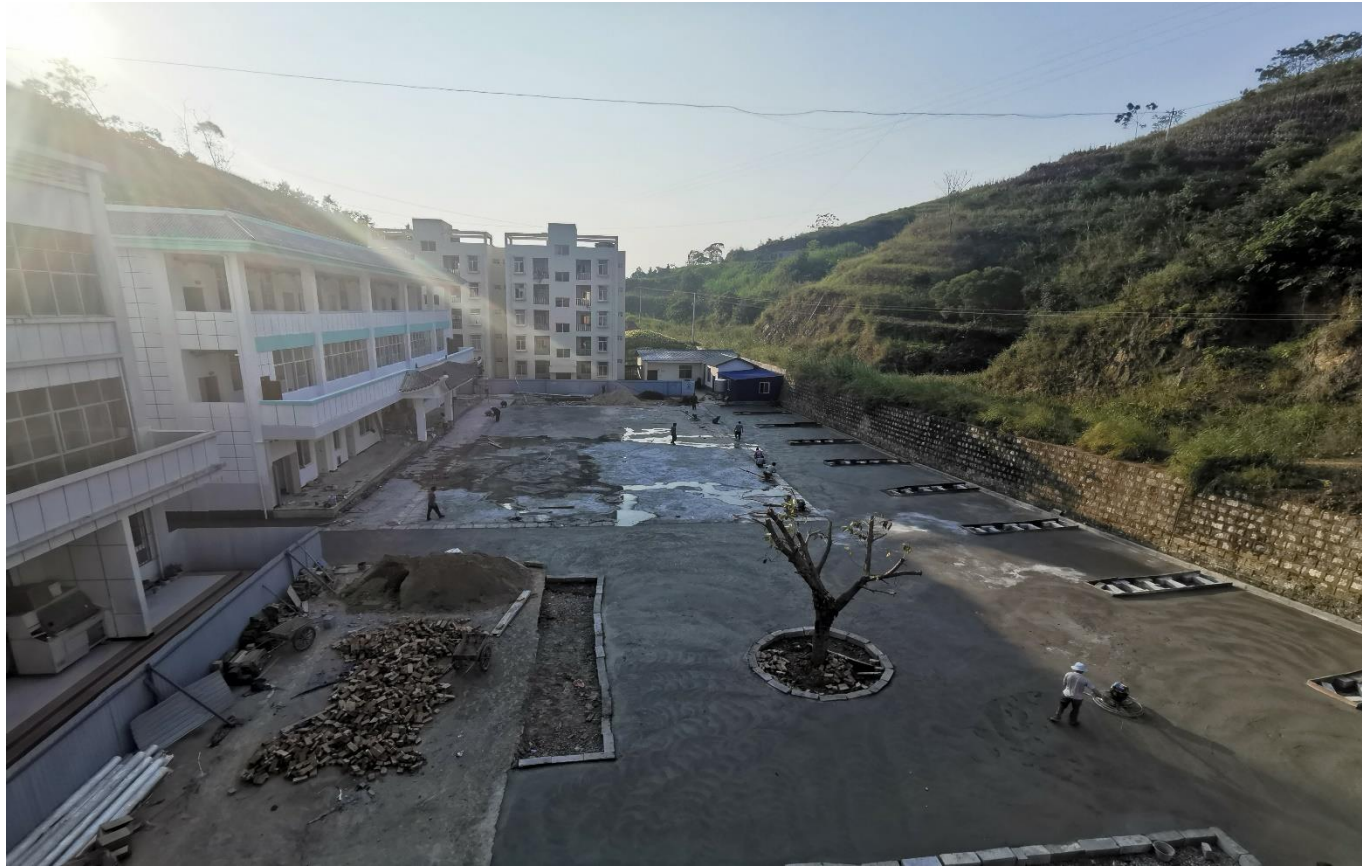
麻栗坡县杨万卫生院业务用房室外附属设施建设进行中
