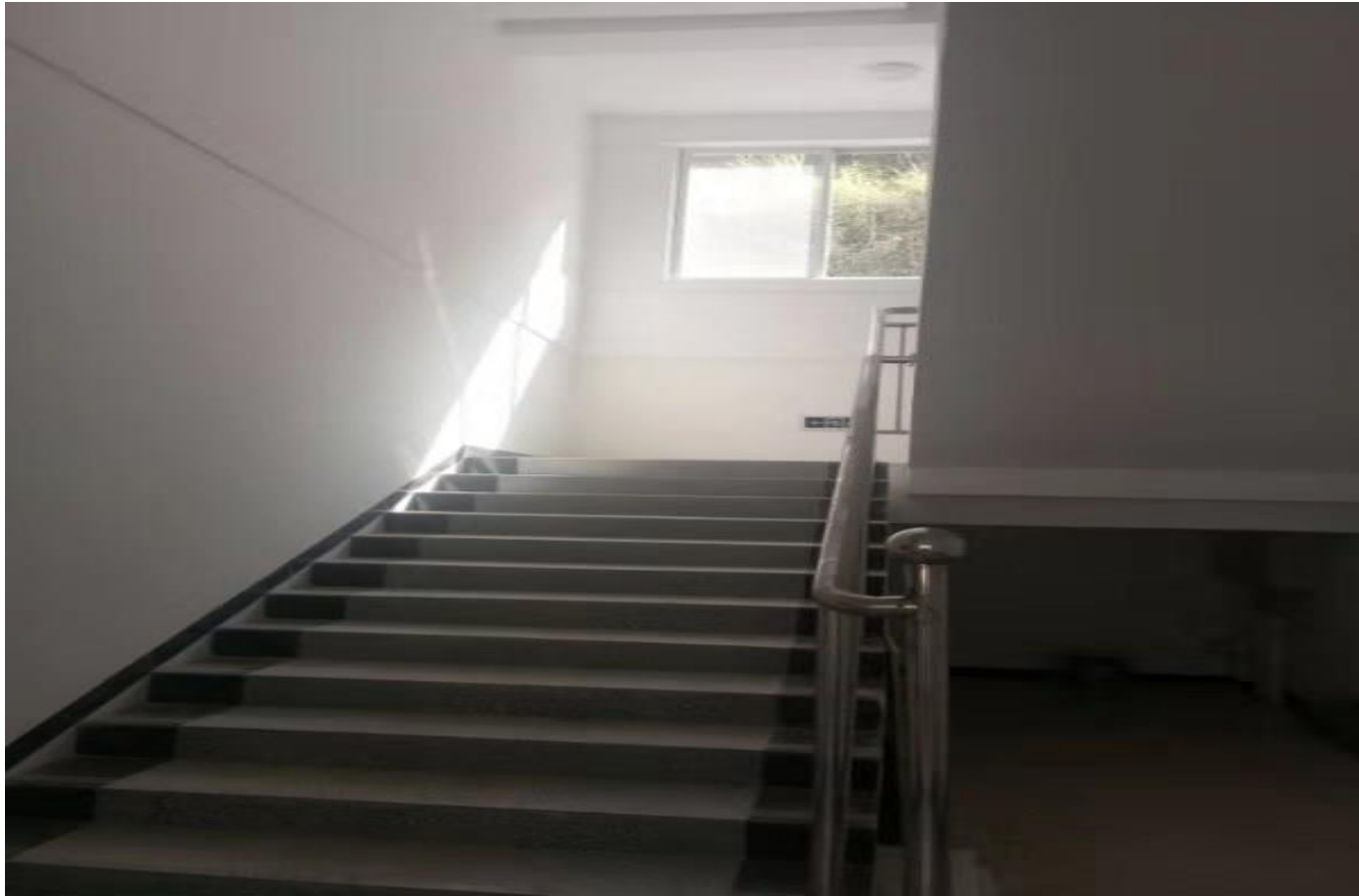
麻栗坡县杨万卫生院业务用房完成楼梯间地板铺装和栏杆安装
