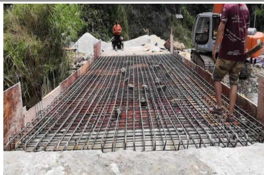
NO.037 新寨桥（在建）
