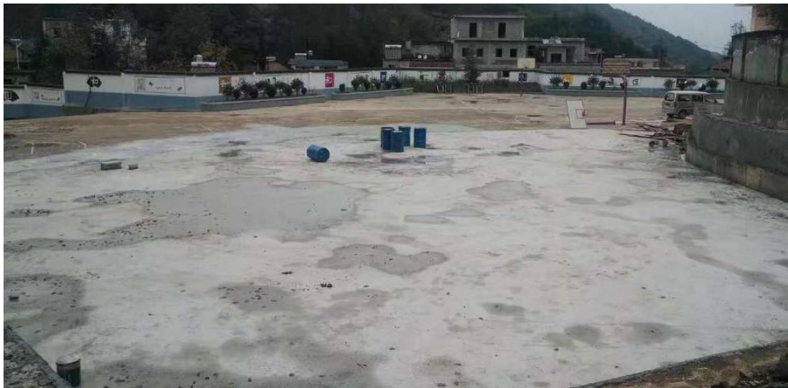
场地硬化完成
