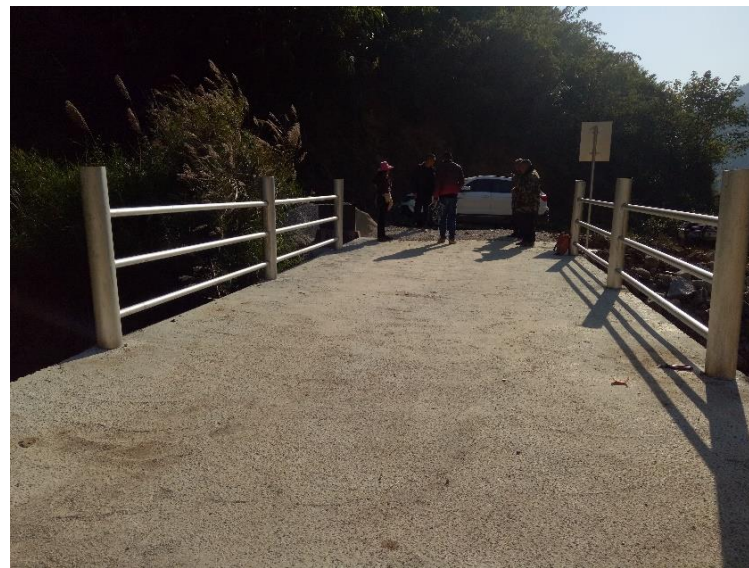
NO.037 新寨桥（竣工）
