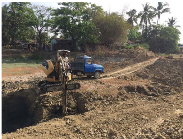
项目施工现场
