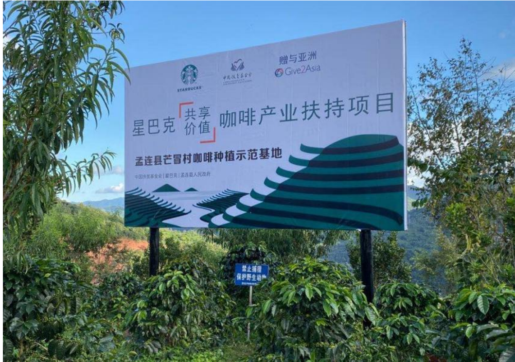
星巴克“共享价值”咖啡产业扶持项目小粒咖啡示范基地标识牌安装
