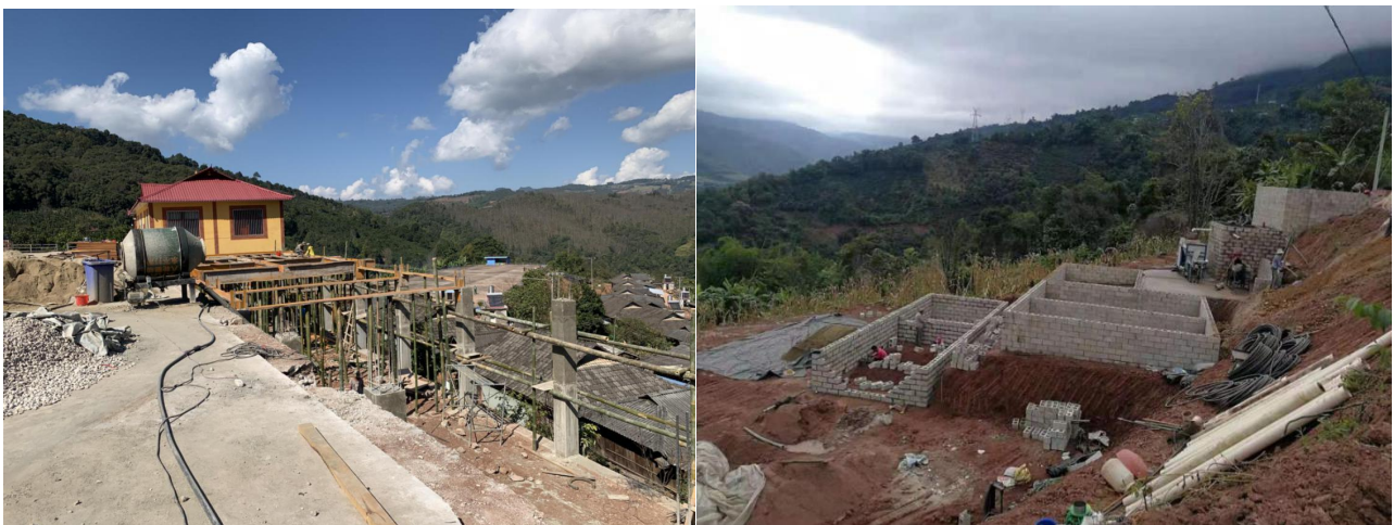
小粒咖啡初加工厂建设现场
