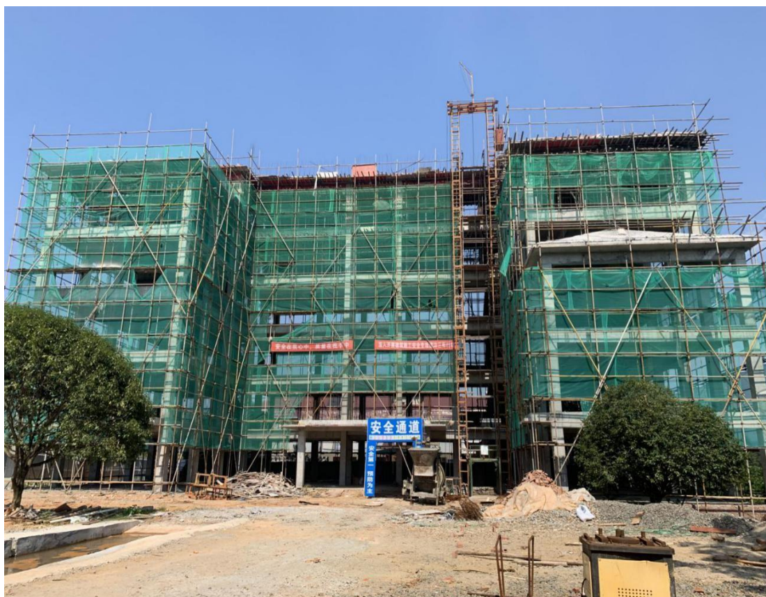
遂川县泉江镇中心养老院院民服务大楼综合楼建设项目封顶
